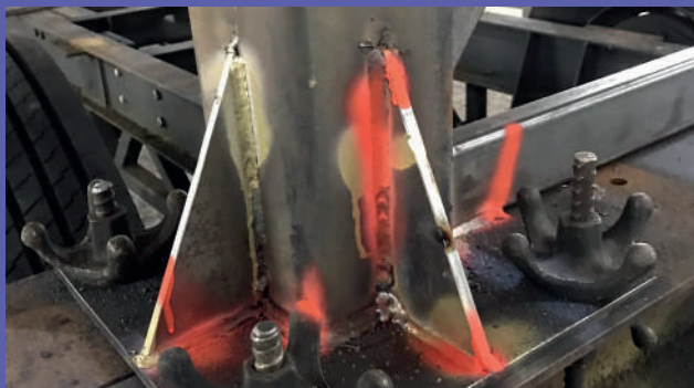
De constructie van de wagen word geplaatst
