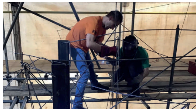
Het uitzetten van de vormgeving
